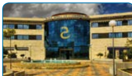
SEDE CAJA ALMODÓVAR Unidades VRF V4+ (28 Kw) (Cáceres)
