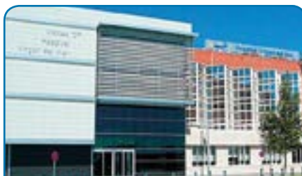
HOSPITAL VITHAS Unidades VRF V4+ (Almería)
