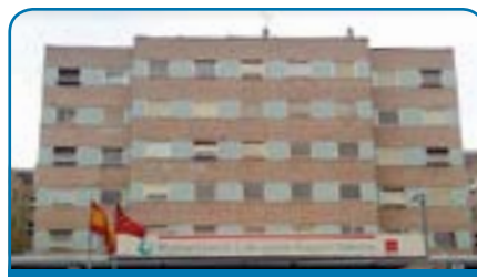
HOSPITAL UNIVERSITARIO GREGORIO MARAÑÓN Unidades Chiller (Madrid)
