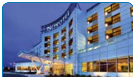
HOTEL NOVOTEL Unidades VRF V4+ (90 Kw) (Málaga)
