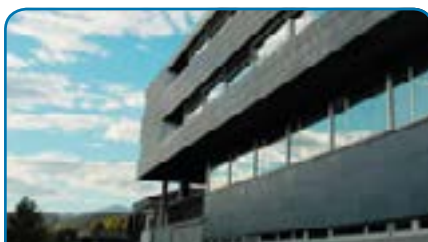
CENTRO GERIÁTRICO Unidades VRF V4+ (61,5 Kw) (Sabadell)
